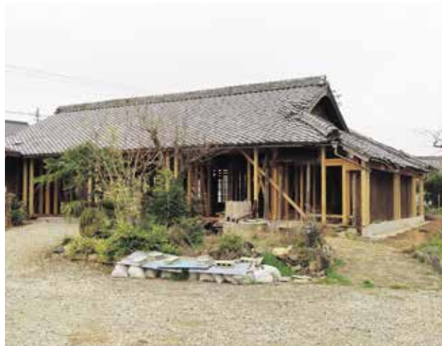
明治10年築の空き家（荻谷内）
