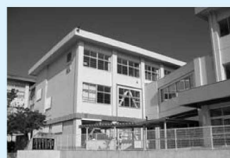
▲深溝小学校校舎地震補強工事
