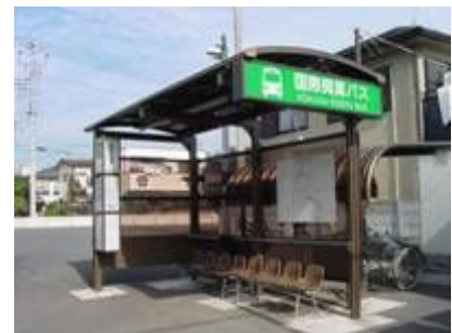
図 バス停の整備例 （埼玉県やすらぎバスステーション整備）
