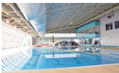
改修工事予定の町民屋内プール
