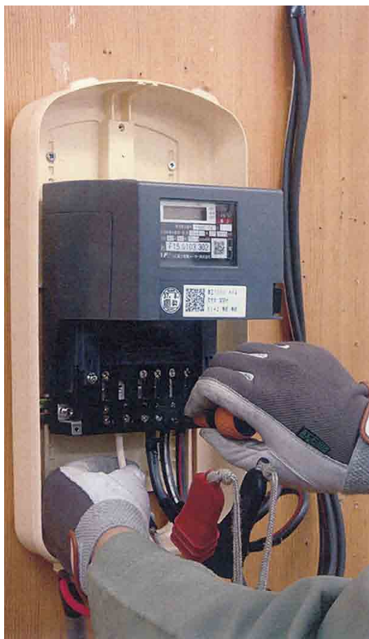
スマートメーター取り付け
