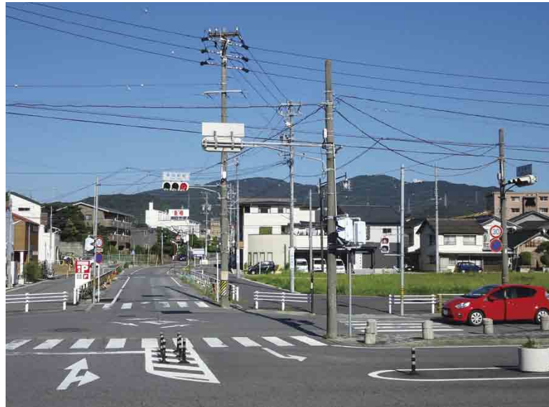
電線地中化する幸田駅前
