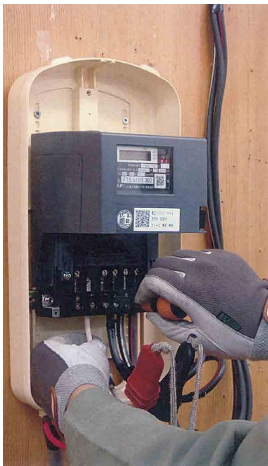
スマートメーター取り付け
