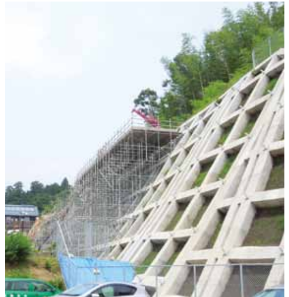
急傾斜地工事（深溝山ノ入）
