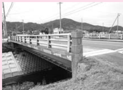
橋梁長寿命化（倉添橋） 4,090万円
