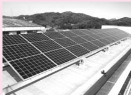
太陽光発電設備設置（南部中学校） 2,268 万円
