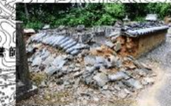
⑥三河地震で崩れた深溝松平家墓所の土塀
