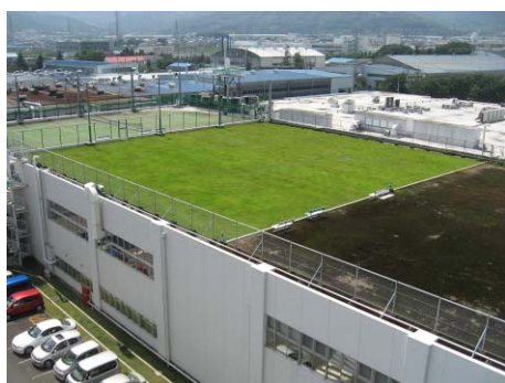
■ 工場の屋上緑化の事例
