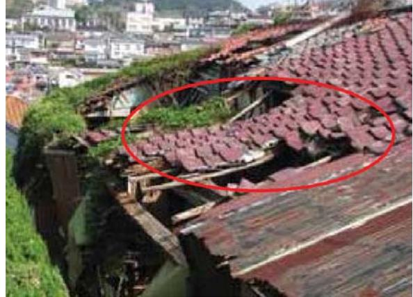
柱、はりの破損や変形が著しく、崩壊の危険性が高い
