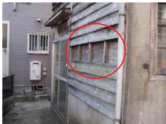
外壁の仕上材の一部がはがれ、下地が露出している
