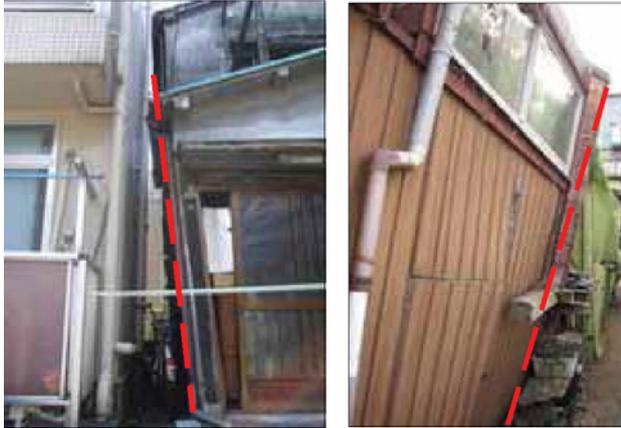
柱の変形が著しく、崩壊の危険がある
