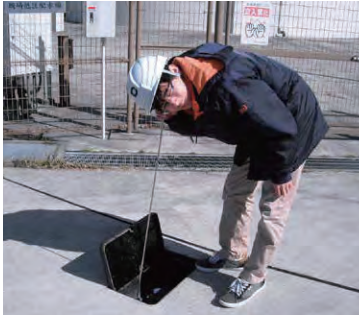
音聴棒による漏水調査
