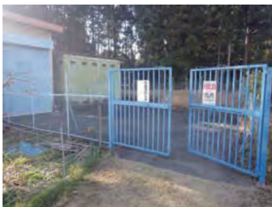
大草ポンプ場
