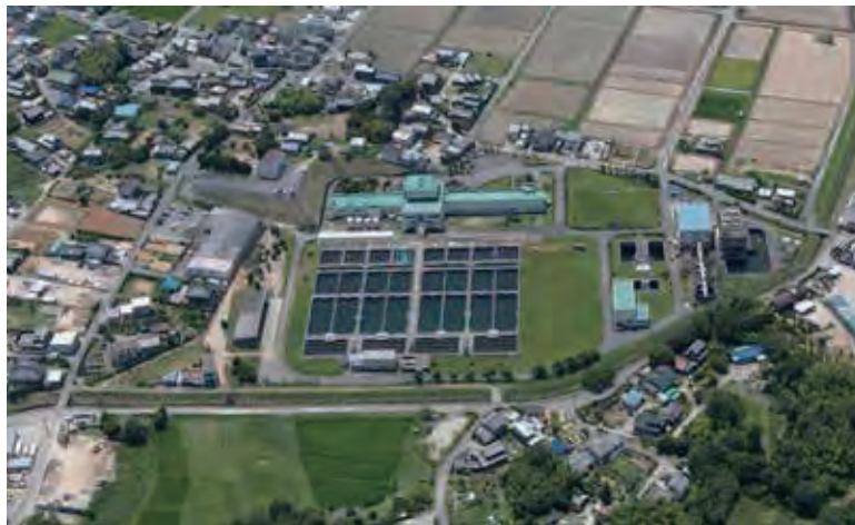
愛知県幸田浄水場
