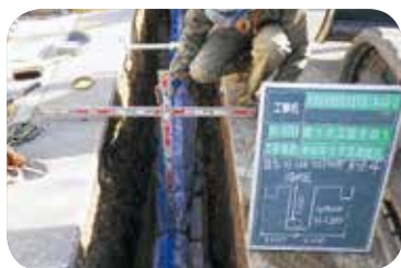
水道管の耐震工事
