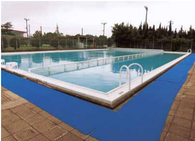
昭和43年に設置されたプール（豊坂小学校）
