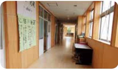
第1期工事が完了(北部中学校)
