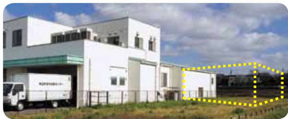
増築予定の学校給食センター
