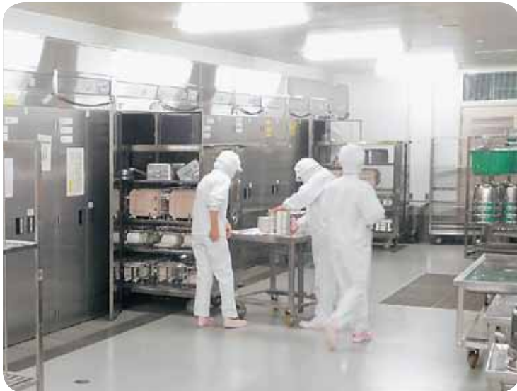
増築整備予定のコンテナ消毒保管庫
