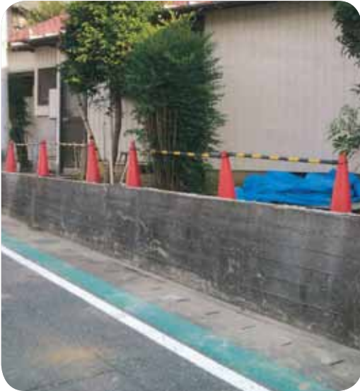
申請第1号で撤去したブロック塀
