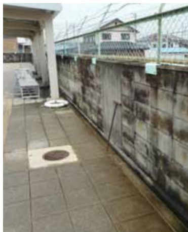
撤去前のブロック塀（幸田中学校）
