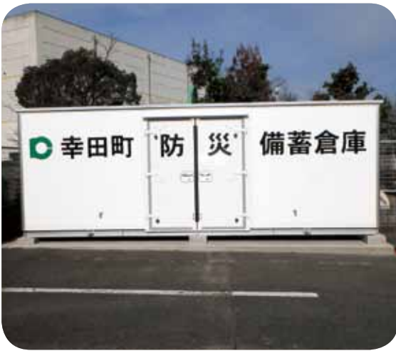
防災備蓄倉庫 (北部中学校)
