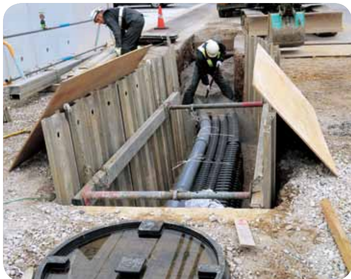
進む電線共同溝工事（幸田駅前）
