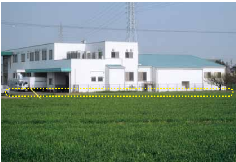
学校給食センターの増築部分
