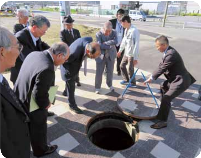
電線共同溝を確認（幸田駅前）
