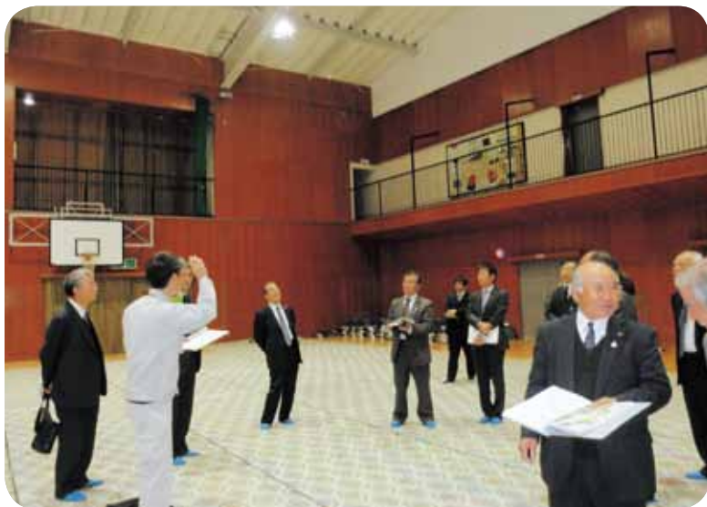
完了した天井耐震化（幸田小学校）
