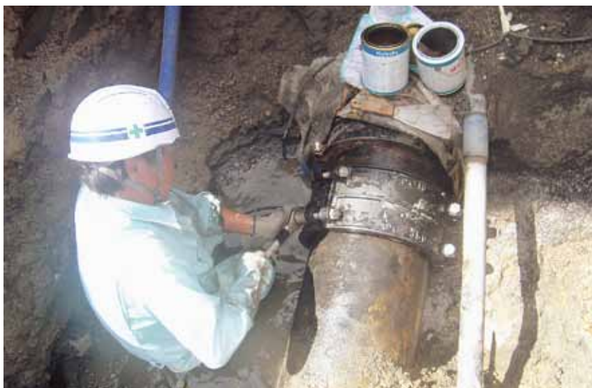
ネジ締めで漏水対策完了（新田区）
