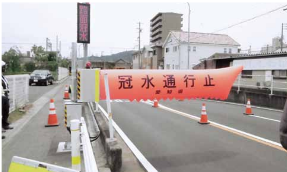
交通遮断機（バルーン式仮封鎖装置）錦田アンダーパス
