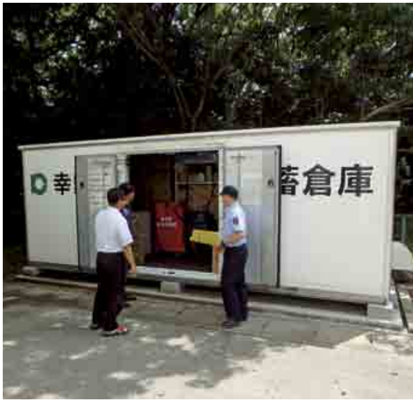
南部中学校の防災備蓄倉庫
