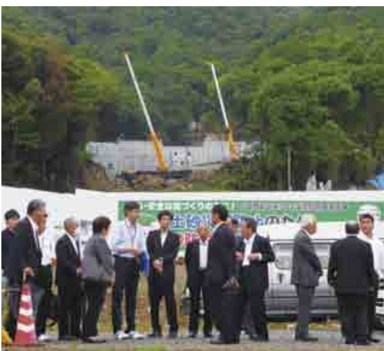
広島市安佐南区八木地区の工事現場
