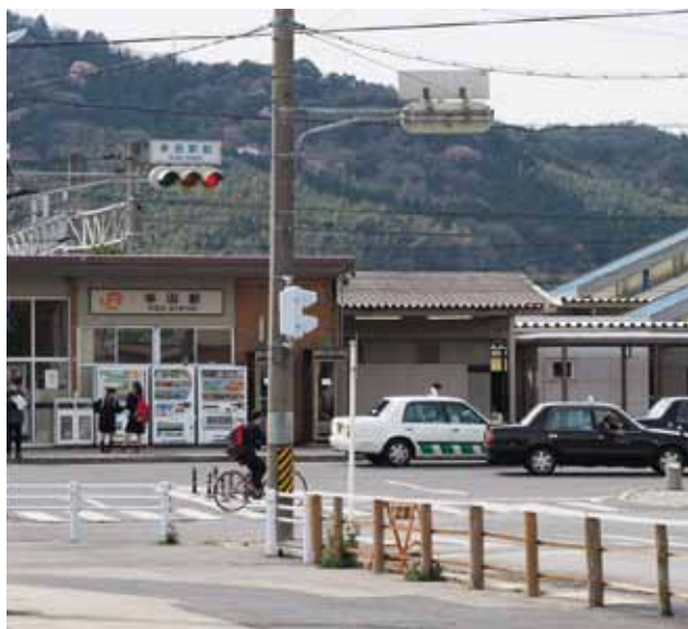
電線地中化工事がすすむ幸田駅前
