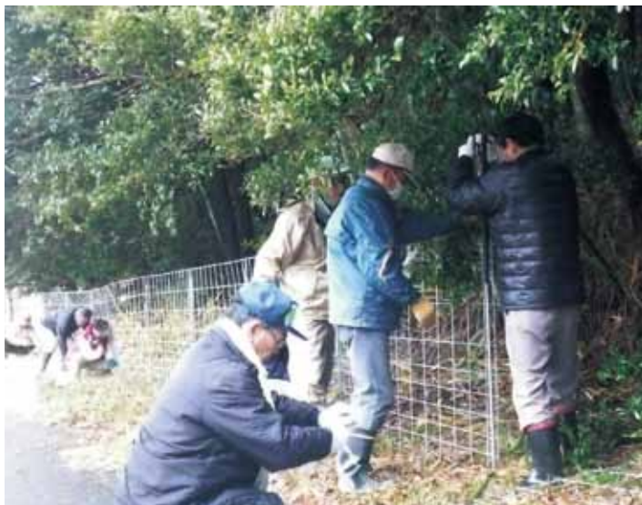
住民パワーで柵設置(里)
