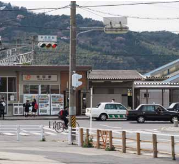
電線地中化工事がすすむ幸田駅前
