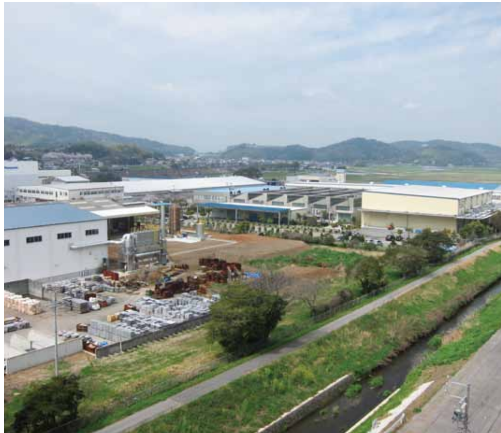
幸田駅西工場団地
