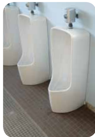
トイレ改修 坂崎・深溝小学校 1500 万円 永野公園 200 万円
