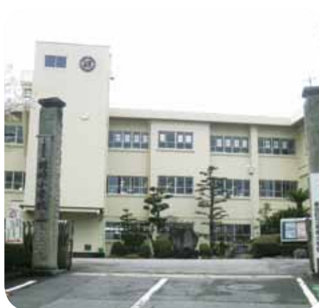
校舎改造工事 坂崎小学校 1800 万円 校舎の増築計画 幸田小学校 2000 万円
