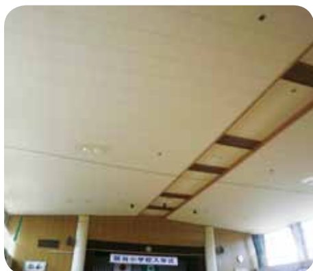
耐震化 体育館吊り天井 荻谷小学校 2500 万円
