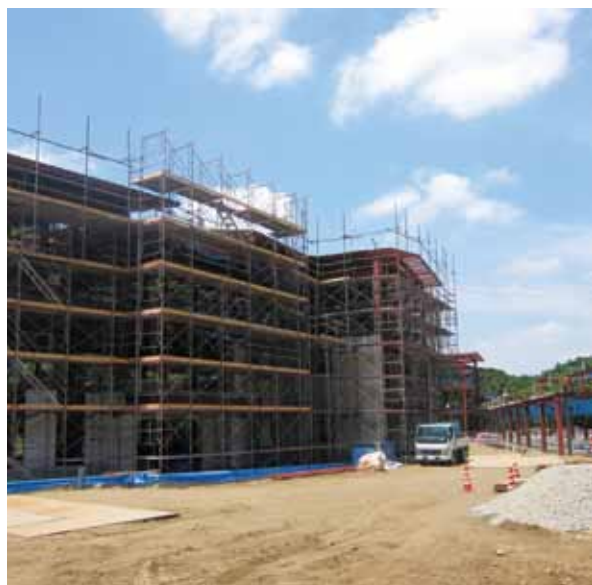
6月下旬の進捗状況（深溝地内）
