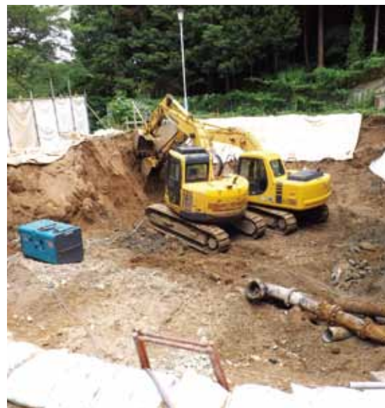
工事中の永野ポンプ場
