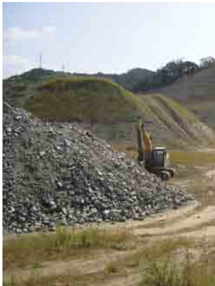
土取り中の須美前山地区
