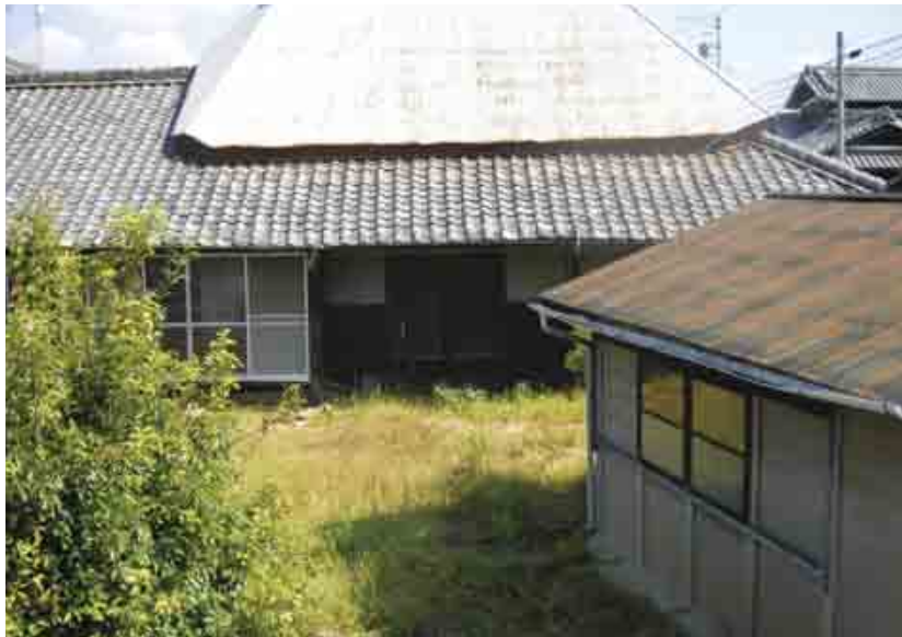
放置された空き家
