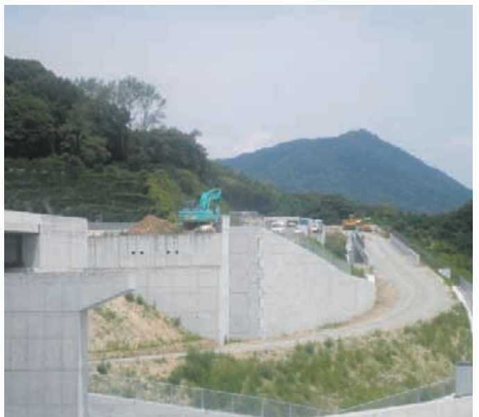
工事中の蒲郡バイパス
