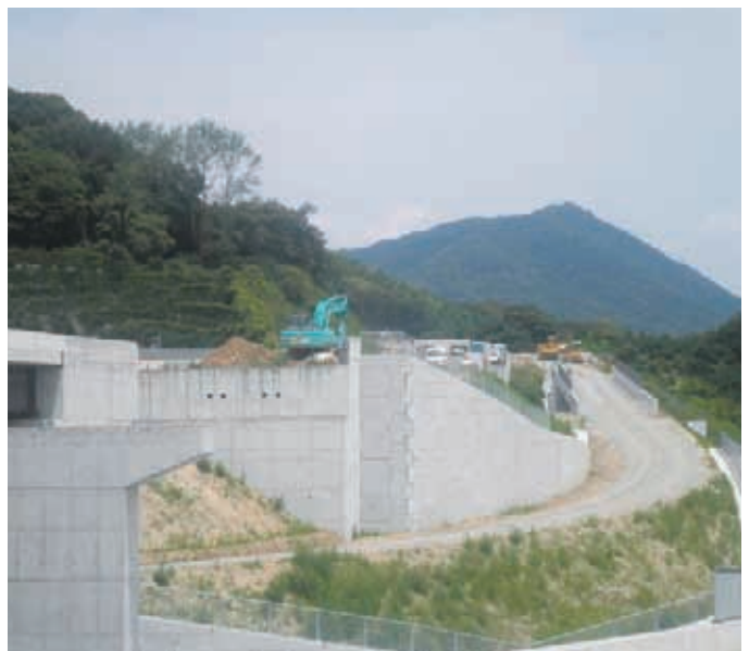
工事中の蒲郡バイパス
