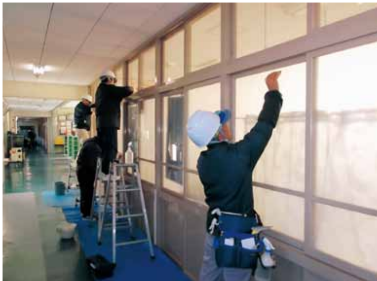
飛散防止フィルム（深溝小学校）
