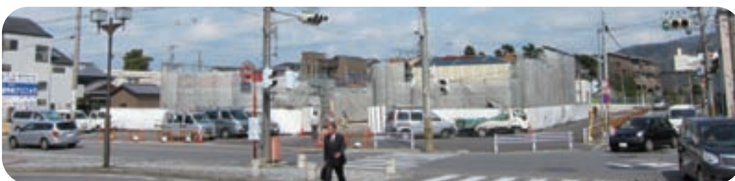
工事がすすむ幸田駅前
