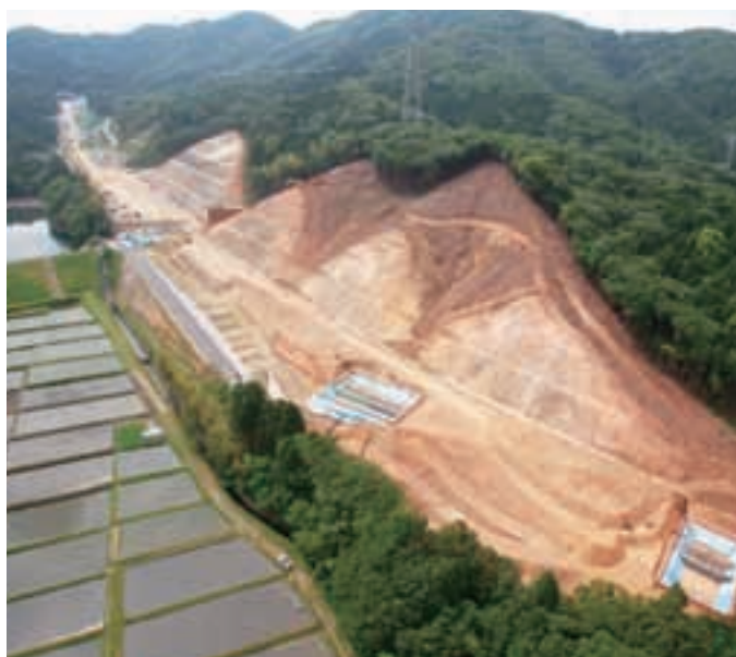
工事中の蒲郡バイパス（芦谷地内）
