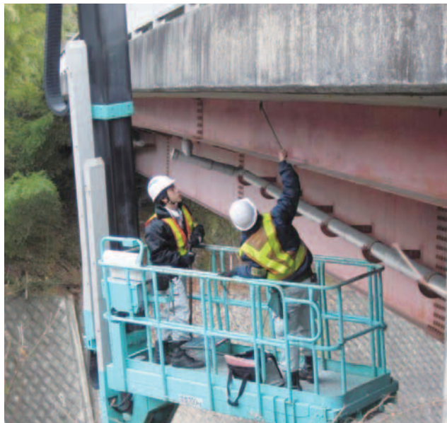
逆川橋の点検
