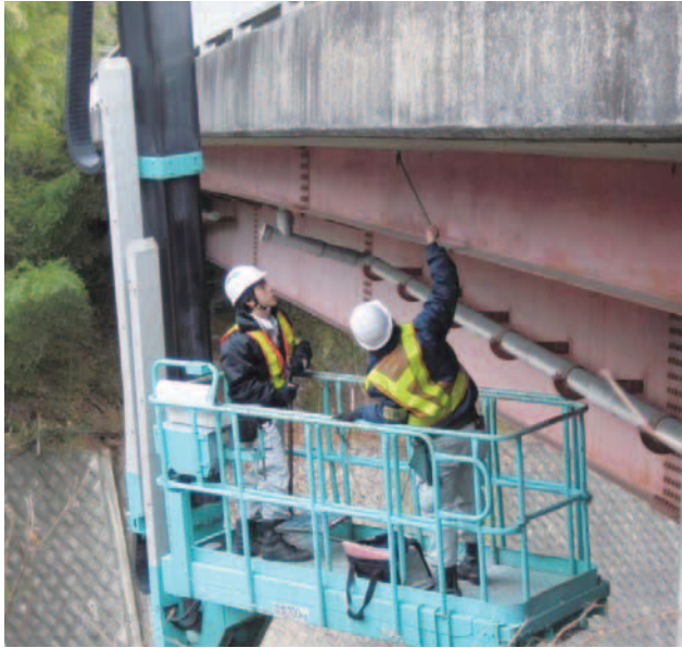
逆川橋の点検
