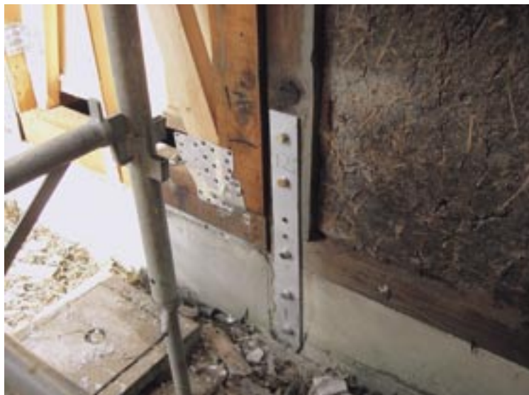
耐震に向け改装中の住宅
