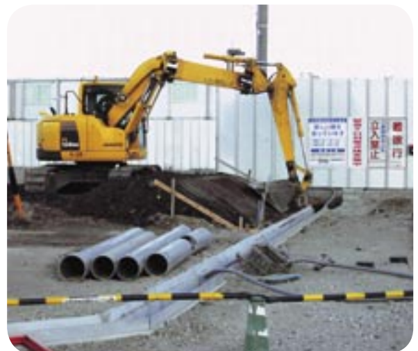
水道工事現場
