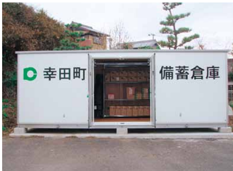
豊坂小学校防災備蓄倉庫
