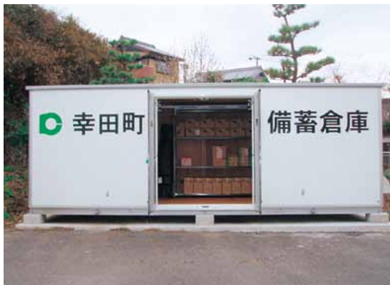
豊坂小学校防災備蓄倉庫
