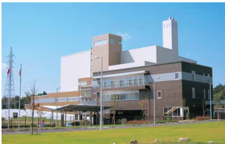
岡崎市中央クリーンセンター外観
