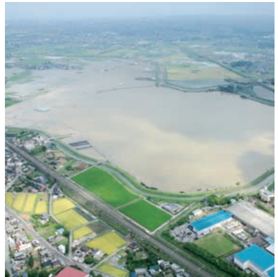
平成20年8月末豪雨で冠水した菱池地内
