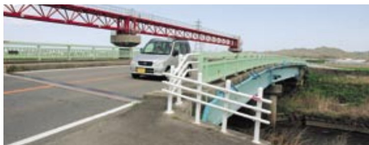
修繕される中吉橋（広田川）
