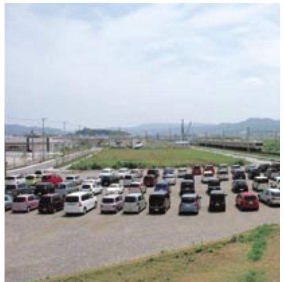
新駅の工事が進む相見地区
