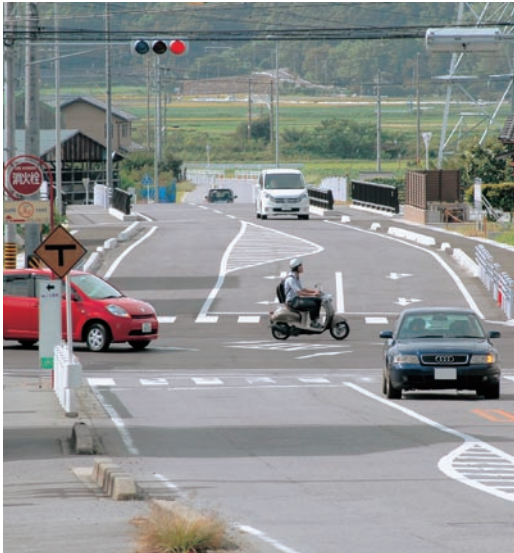
開通した野場横落線（地藏堂地内）
