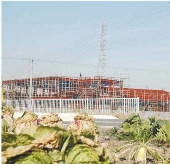
建設が進む給食センター
